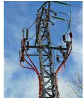
Por sus características, estos cables eléctricos de Media Tensión pueden utilizarse en instalaciones fijas interiores, exteriores o enterradas.
